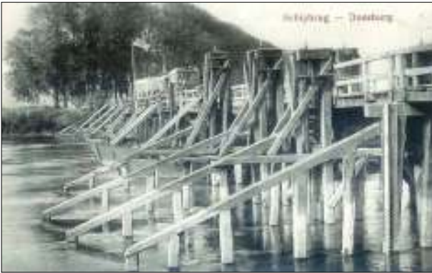
Afb. 3: de schipbrug over de IJssel bij Doesburg
