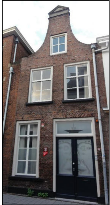
St. Jorisstraat 12, het postkantoor van De Sta.
