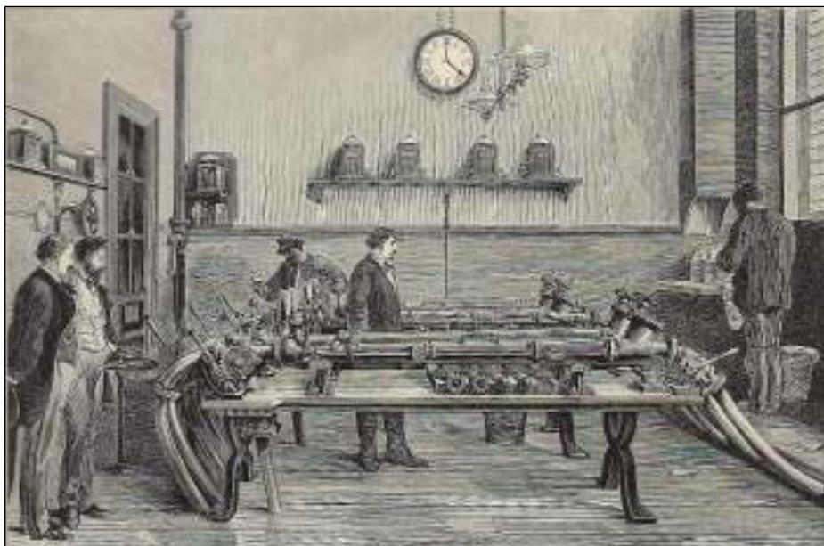
Een buizenpostcentrale (Die Weltpost)
