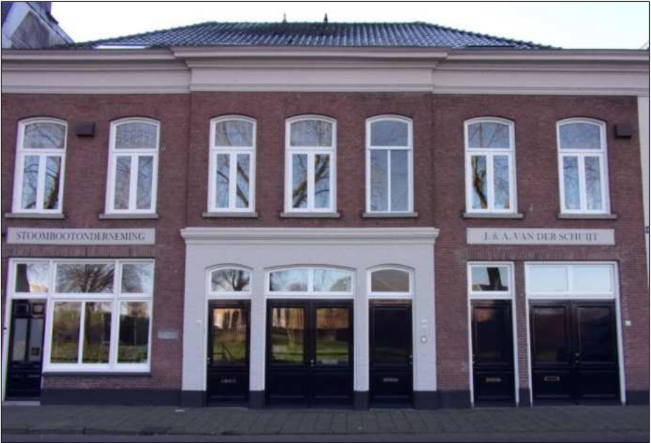
Aan de gevel van het pand aan de Zuid-Willemsvaart waar vroeger de Rotterdamse stoomboot aanlegde is thans nog te lezen: 'Stoombootonderneming J. & A. van der Schuijt'.
