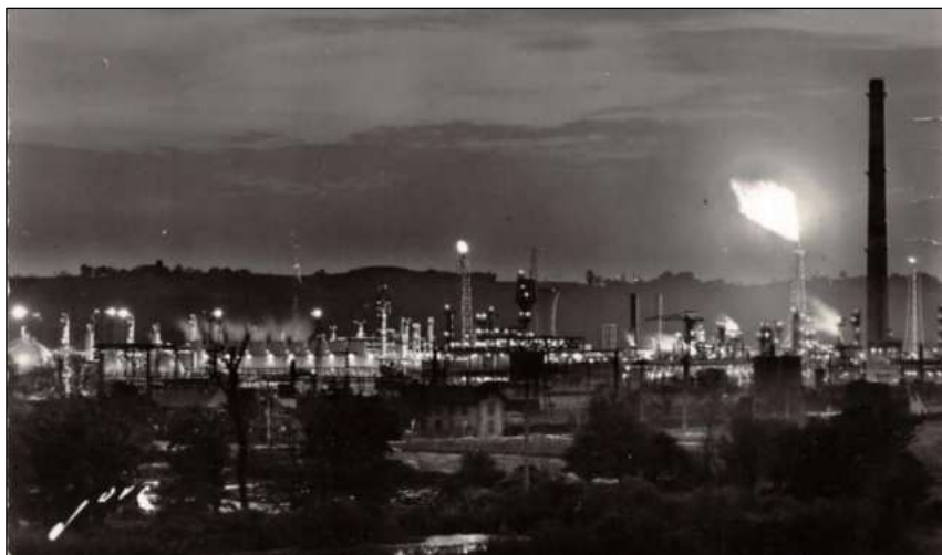
Nachtelijke impressie van het gaswinningscomplex te Lacq
