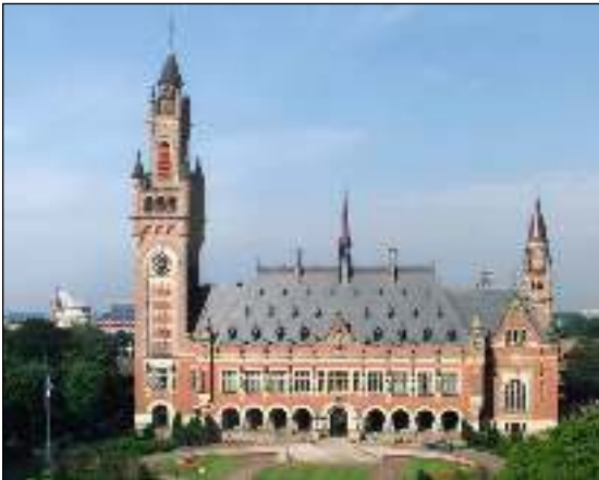
Afb. 2: Vredespaleis in Den Haag, geopend in 1913, de werkplek van Åke Hammarskjöld.
