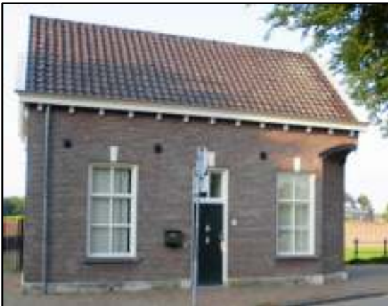
Afb. 13: Het brugwachtershuisje bij de Boombrug met de afgeschuinde hoek.
